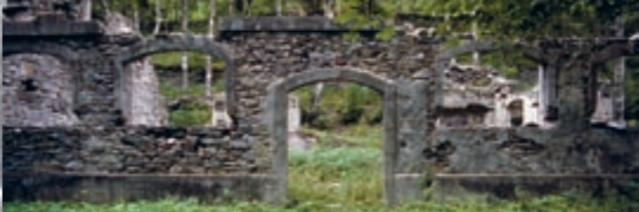
Ruine eines Werkgebäudes auf dem Minenboden
