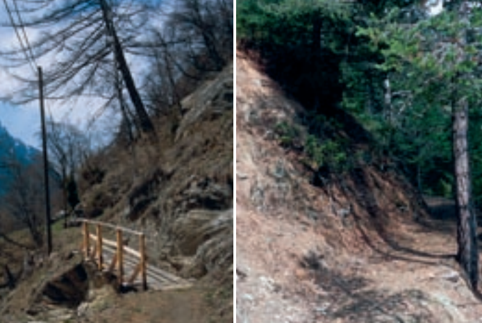
Wegpartien des renovierten Weges im Gantertal
